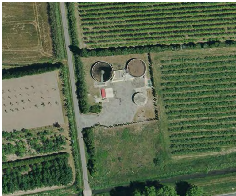
Vue aérienne de la station d'épuration
