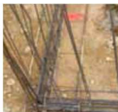
Noeud de chaînage - Continuité mécanique
