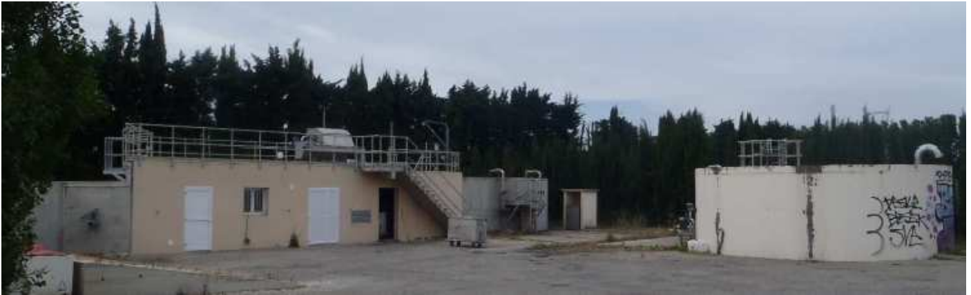
Figure 2 : la station d'épuration d'Eygalières (Source Cereg Ingénierie)
