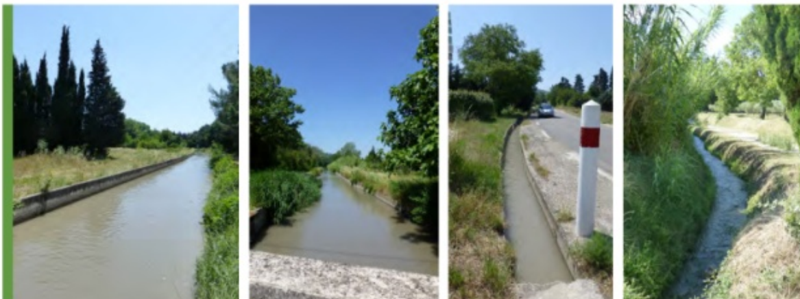
1 - Canal vu depuis la D24 / 2 - Canal passant sous le chemin de Cantos / 3 - Filiole maçonnée le long de la D24 / 4 - Filiole en tranchée chemin du Cèbe.
